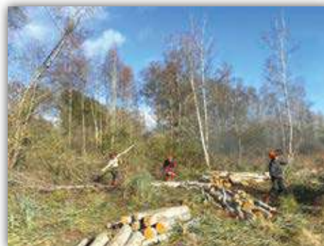
Travaux de réouverture dans les marais de la Souche
